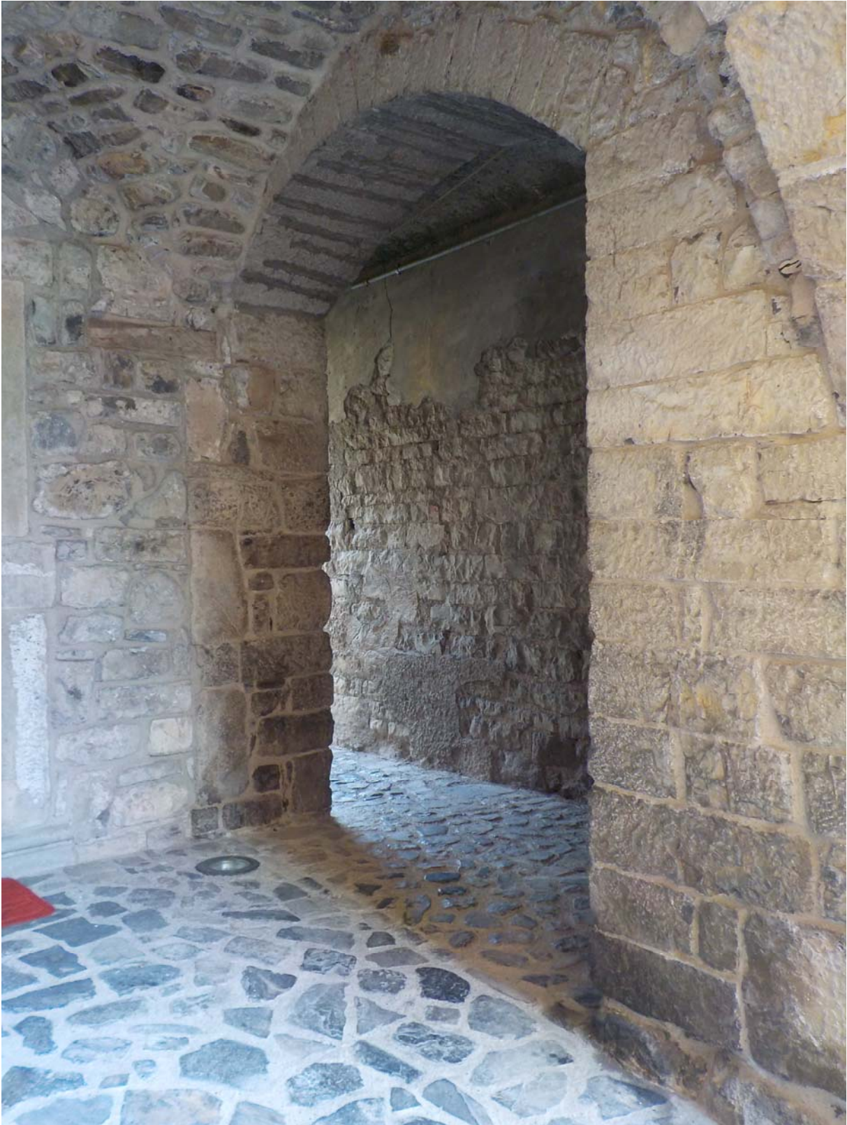
Des passages qui conduisent aux espaces verts situés à l'arrière des maisons.
